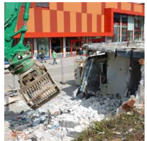
Abriss des alten Marktmeistergebäudes.
