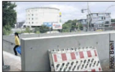
Der Tunnelkopf am Bahnhofsvorplatz, dahinter die Parkhauswendel
