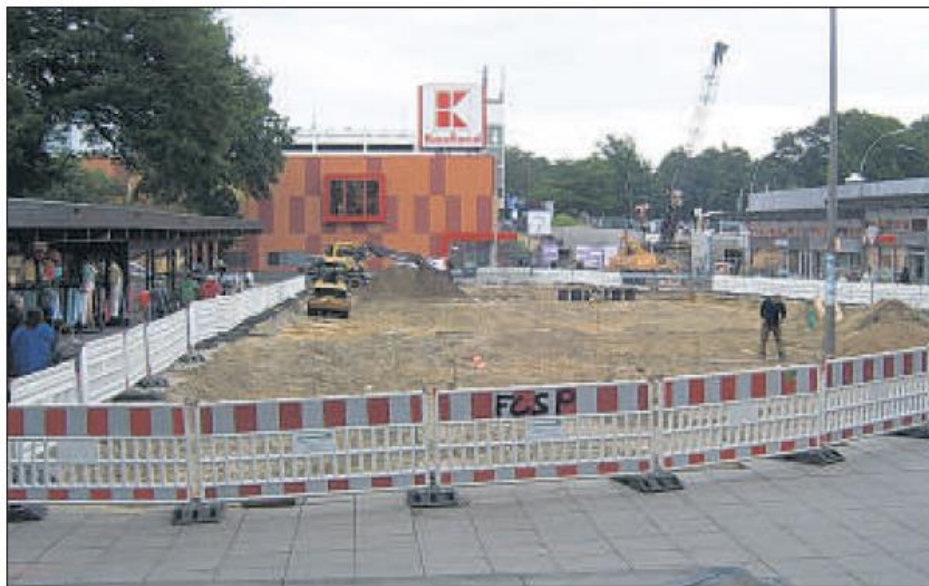
Bis die Bauarbeiten beendet sind und der Wochenmarkt zurückzieht, brauchen die Geschäftsleute am Langenhorner Markt noch einige Geduld
