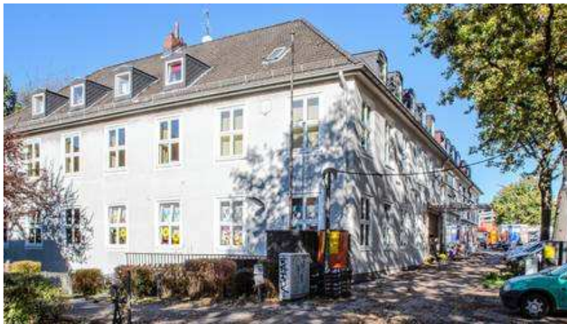
Frisch renoviert: Das Langenhorner Bürgerhaus. Foto: ers
