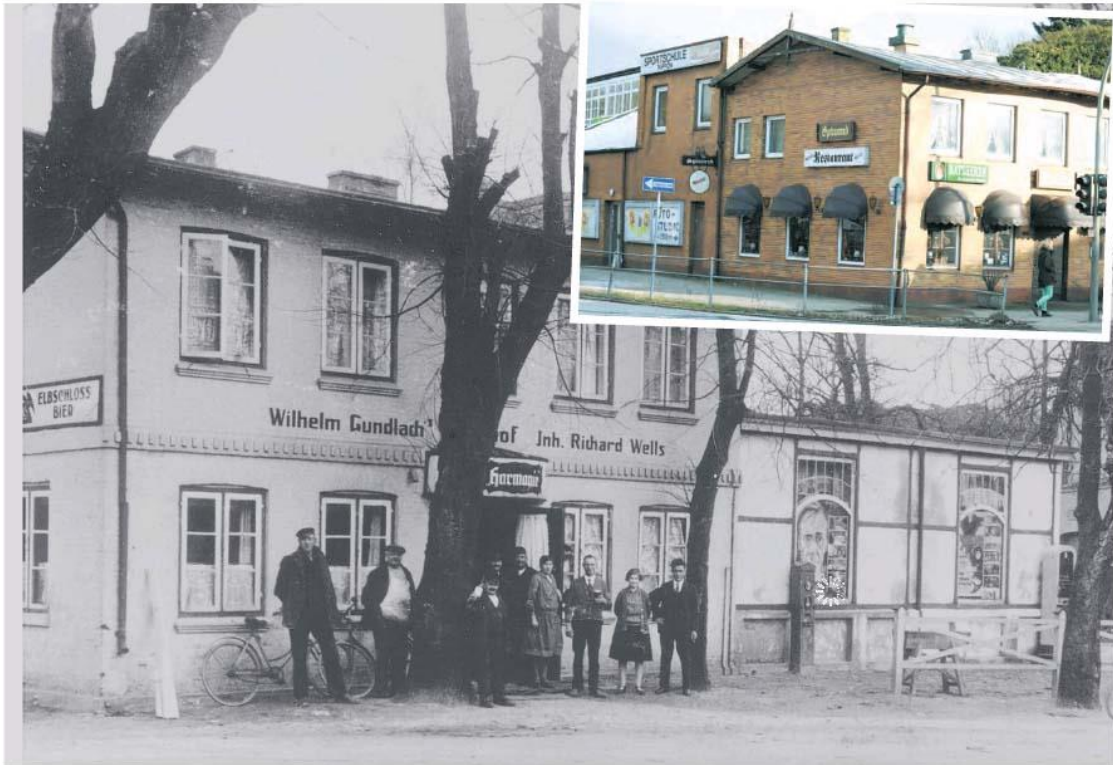
Das große Foto zeigt das Gasthaus „Zur Harmonie“ im Jahr 1928, das kleine den Zustand heute. Im Oktober soll das historische Gebäude abgerissen werden
